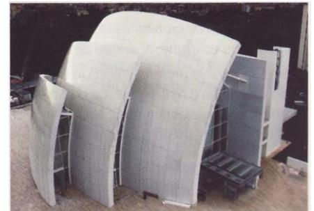
L'église Dives in Misericordia, à Rome, construite en 2000 avec du béton comportant des nanoparticules de dioxyde de titane.
